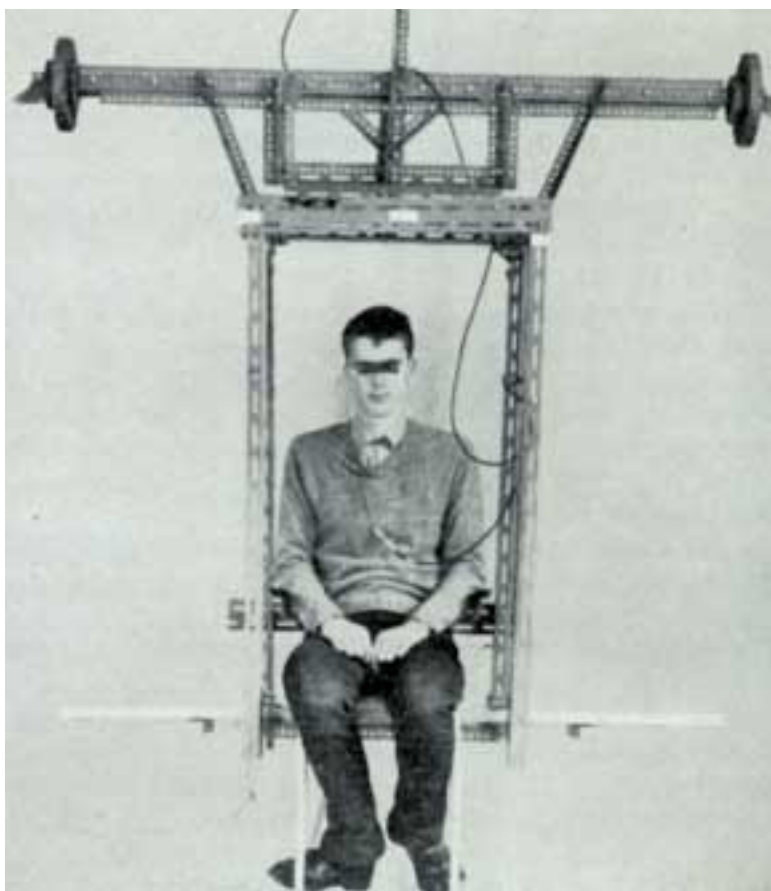
Figuur 11. Een prototype van de torsieschommel (voordracht Oosterveld, 1965).
